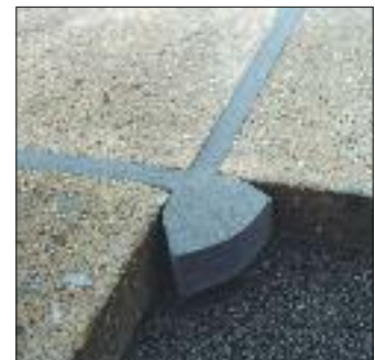
Abdichten von Betonfertigteilen
