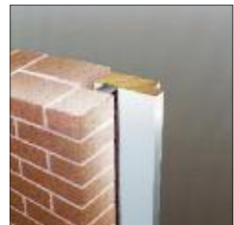
Abdichtung von Fensterfugen mit Innenanschlag
